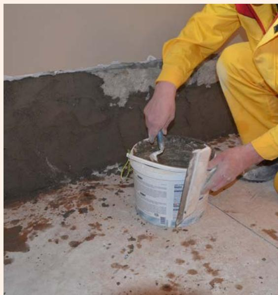
per cui in fase di applicazione del trattamento antisale, per essere sicuri che la muratura abbia completamente assorbito il prodotto, bisogna portare la muratura stessa a saturazione.
