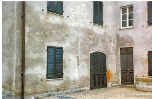
Figura 2 – Edificio in cui il livello di umidità è differente nelle pareti per effetto dell'esposizione. A Nord, per la ridotta evaporazione superficiale, il livello è più alto.
